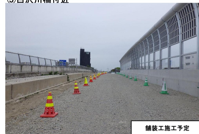
③白沢川橋付近
