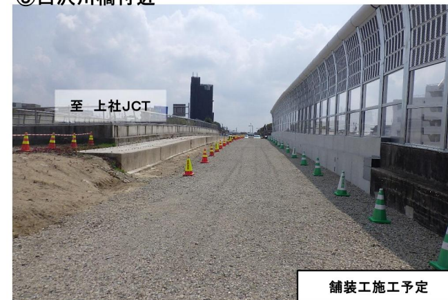
③白沢川橋付近
