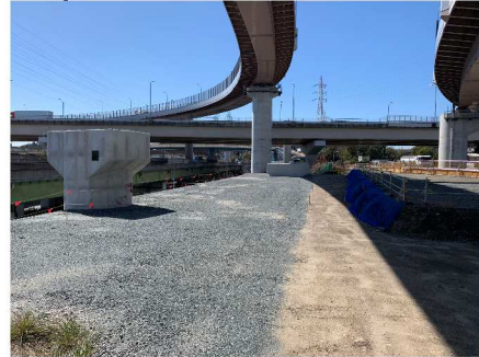
③Eランプ橋 (PE3→PE4方向)
