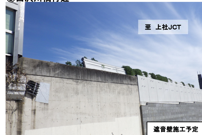
③白沢川橋付近
