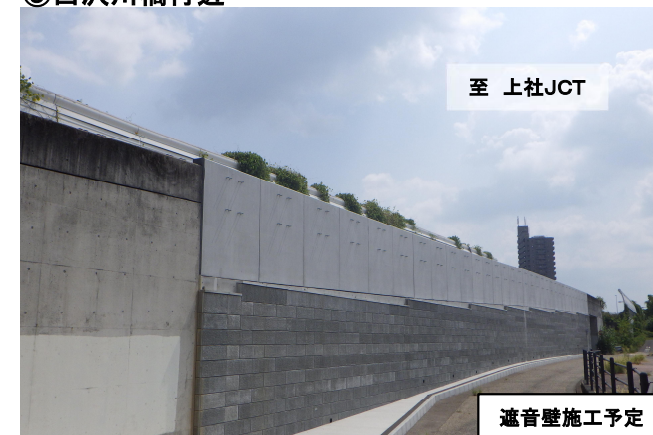
③白沢川橋付近
