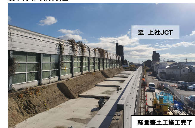
③白沢川橋付近
