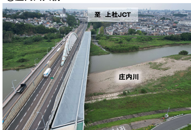
②庄内川大橋
