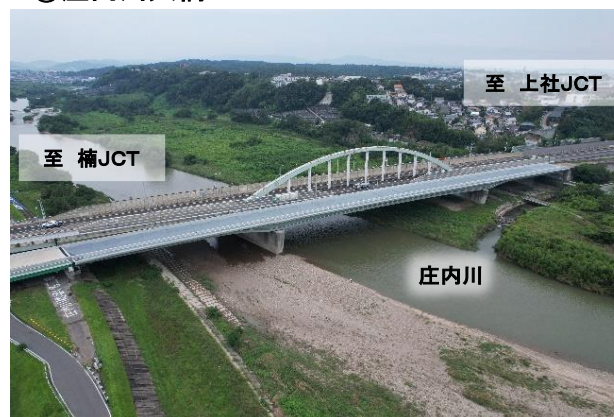
②庄内川大橋
