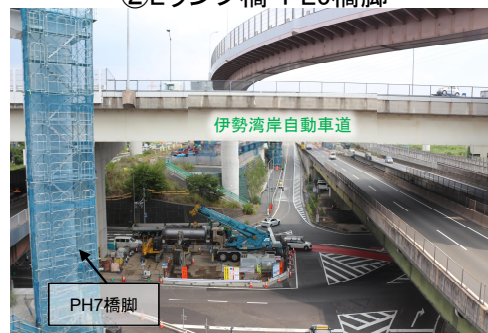
②Eランプ橋・PE5橋脚
