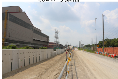
道路改良工事施工中
