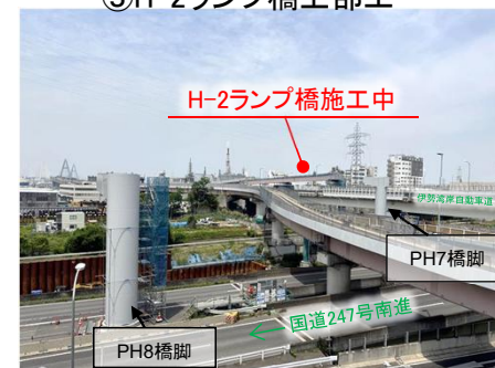
③H-2ランプ橋上部工
