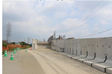
道路改良工事施工中
