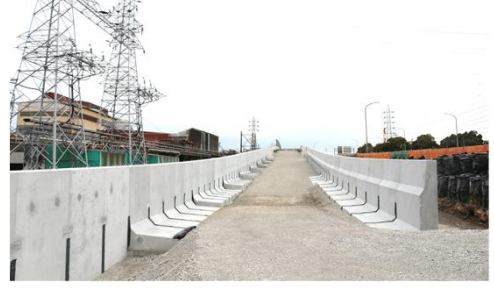
擁壁工施工完了
