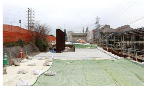
軽量盛土施工中
