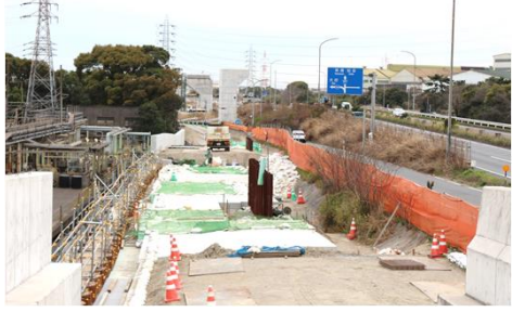
軽量盛土施工中
