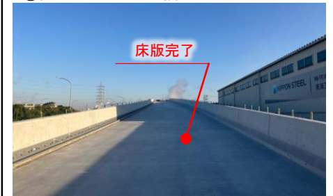
⑦荒尾OFFランプ橋(AL1→PL4方向)
