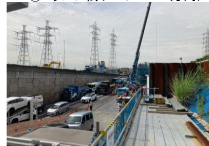
④Eランプ橋 (PE6→PE7方向)
