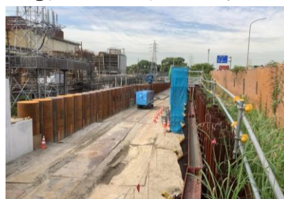
⑦荒尾地区道路 (起点→終点)
