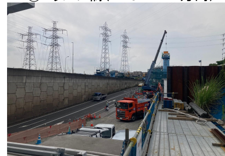
④Eランプ橋(PE6→PE7方向)
