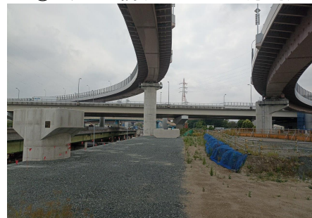
③Eランプ橋(PE3→PE4方向)
