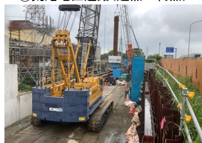
⑦荒尾地区道路 (起点→終点)
