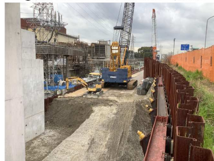
⑦荒尾地区道路(起点→終点)
