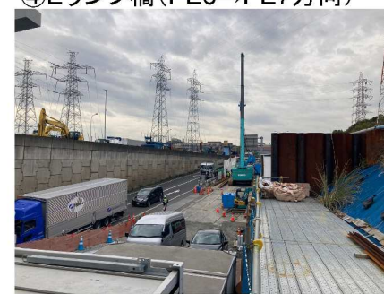
④Eランプ橋(PE6→PE7方向)
