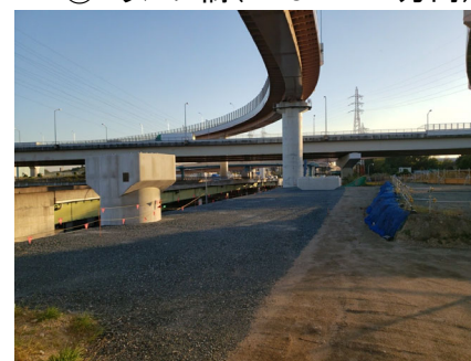
③Eランプ橋 (PE3→PE4方向)
