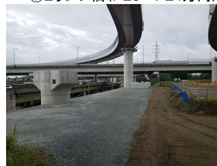
③Eランプ橋(PE3→PE4方向)
