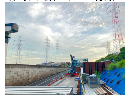
④Eランプ橋(PE6→PE7方向)
