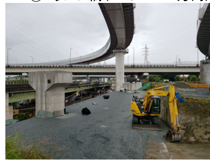
③Eランプ橋(PE3→PE4方向)
