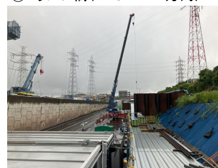
④Eランプ橋(PE6→PE7方向)
