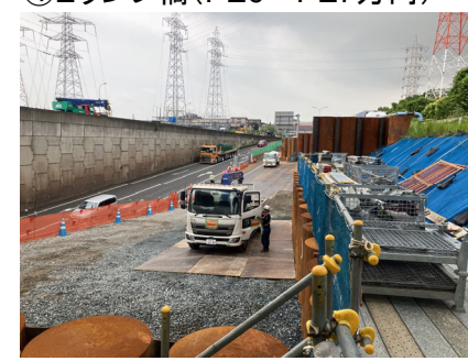
④Eランプ橋(PE6→PE7方向)
