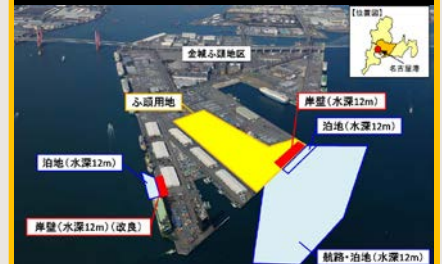
金城ふ頭国際物流ターミナルの整備状況
