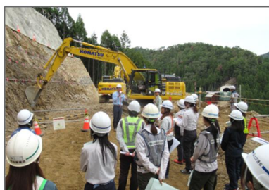
DX技術を活用した現場を見学
