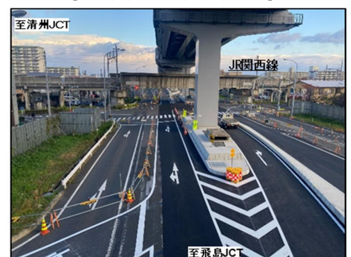
【西南部:JR 関西線交差部付近の様子(R6.2)】
