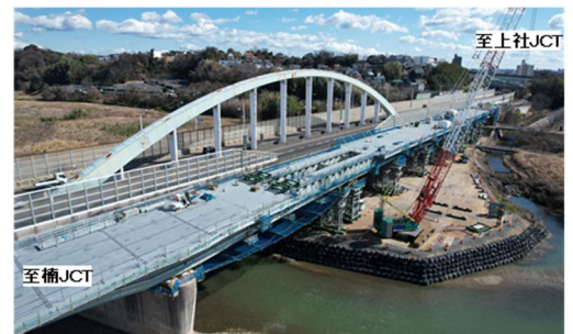
【東北部:庄内川渡河部の施工状況(R6.2)】
