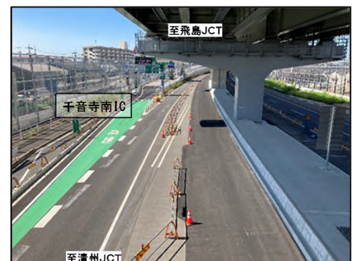
【西南部:千音寺南IC付近の様子】
