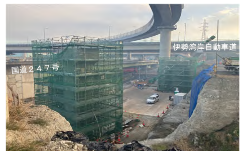
写真②【東海JCT Eランプ橋 北→南方向】
