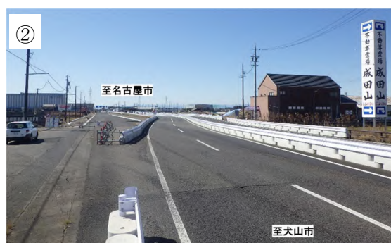
【切り回し道路付近の様子】
