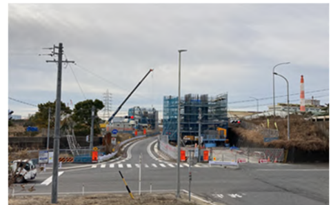
写真③【荒尾 OFF ランプ橋 北→南方向】
