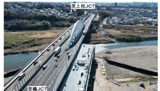
【東北部:庄内川渡河部の施工状況】
