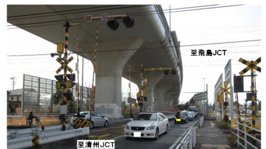
【西北部:名鉄津島線交差部の様子】
