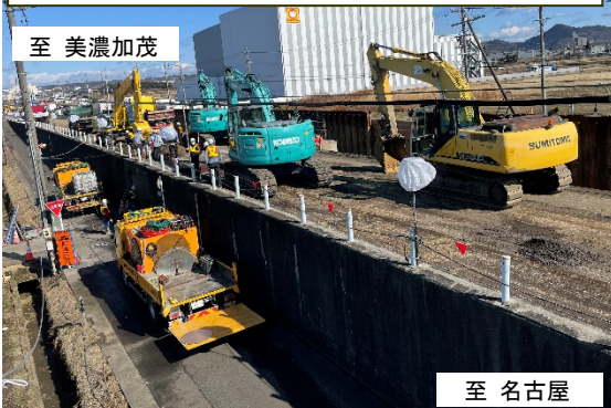
写真③ 扶桑4号函渠6車線化集中工事 (R3.2)
