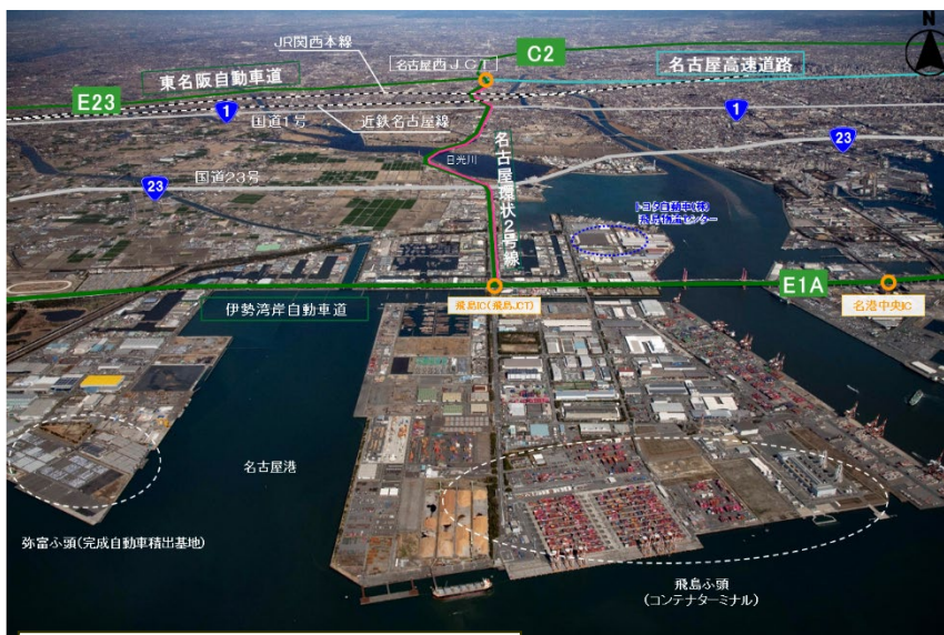
写真① 近畿自動車道伊勢線(名古屋西～飛島)
