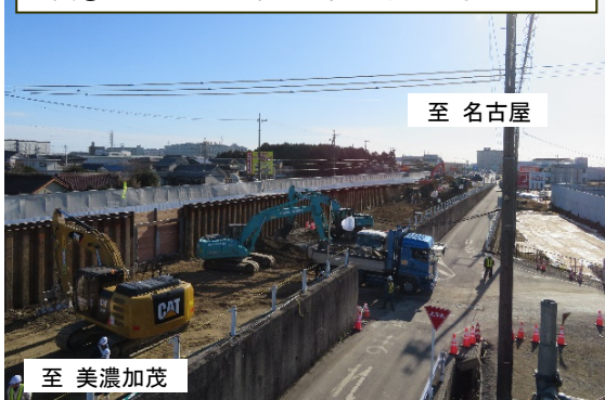
写真② 大口1号函渠6車線化集中工事 (H29.12)
