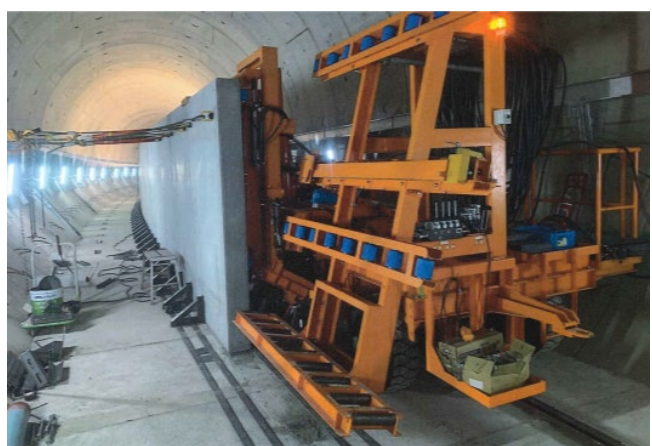
内部構築(中壁)設置工事の状況
