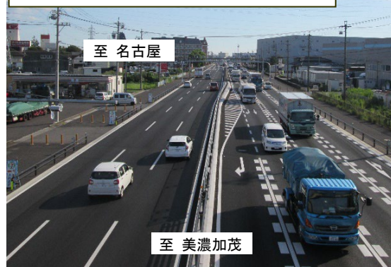
写真① 6車線化完了区間 (R1.9)
