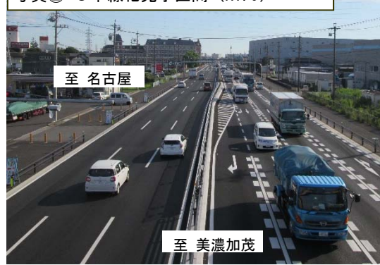
写真② 6車線化完了区間（R1.9）
