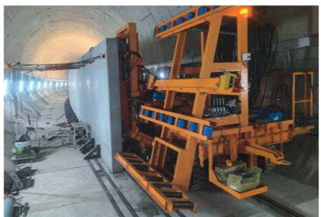
内部構築(中壁)設置工事の状況
