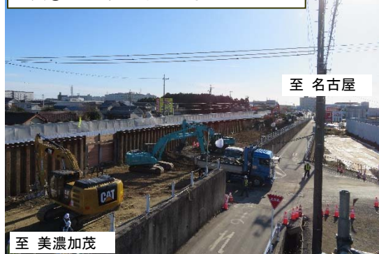
写真① 6車線化集中工事（H29.12）
