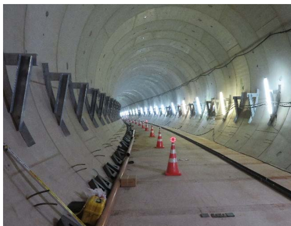
本体掘削・インバートコンクリート施工時点
