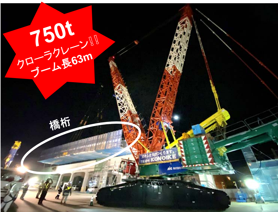
橋げたを吊り上げて慎重に旋回
