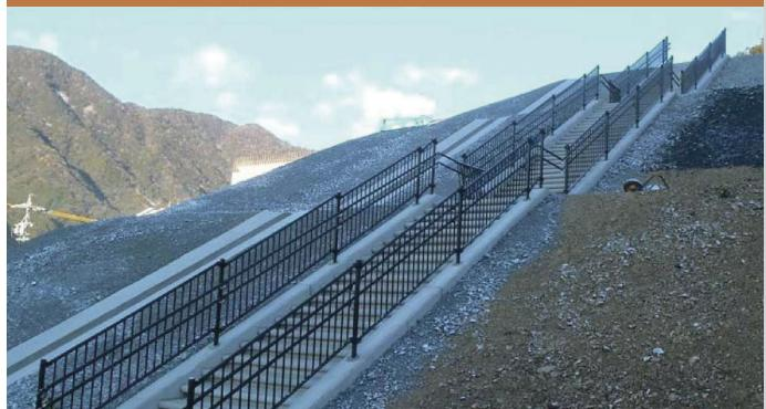
南海トラフの巨大地震による津波は、到達するまでの時間が短いので、近くの高台に速やかに逃げる必要があります。津波が押し寄せる地域の高台の道路には、避難階段等の設置を進めています。普段は危険防止のために柵が閉じていますので、蹴破り扉を壊して侵入します。地域住民と連携して、防災訓練も実施しています。
