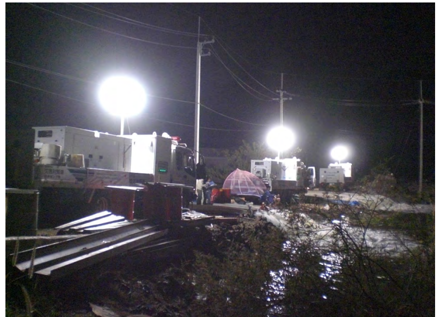
24時間体制の排水作業(夜間巡回有り)
