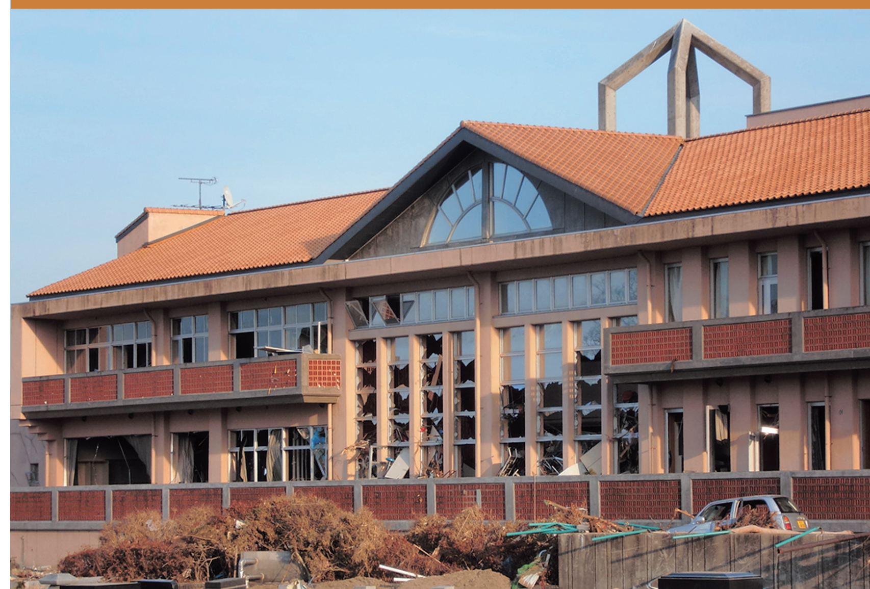
窓を大きくして津波の威力を逃すように建てられた校舎
