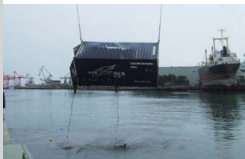
航路啓開状況・仙台塩釜港 (沈んだコンテナの除去)
