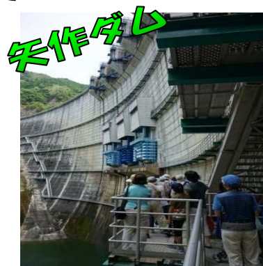
通廊からダムを見上げる
