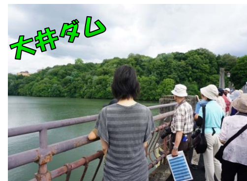
日本初のダム式発電所(大正13年完成)のある大井ダムの天端を歩く
