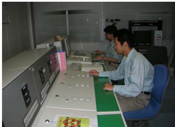
↑ コンジットゲート開閉操作中
