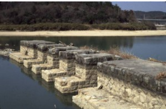
明治用水旧頭首工と船通し閘門
