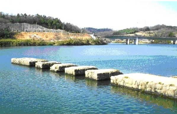
農業用水史上初期の横断堰堤で、服部長七考案の人造石による大規模な堰堤の現存する唯一の例と云われている。
