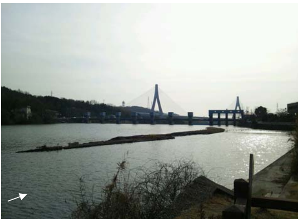
・東海環状自動車道と明治用水頭首工
