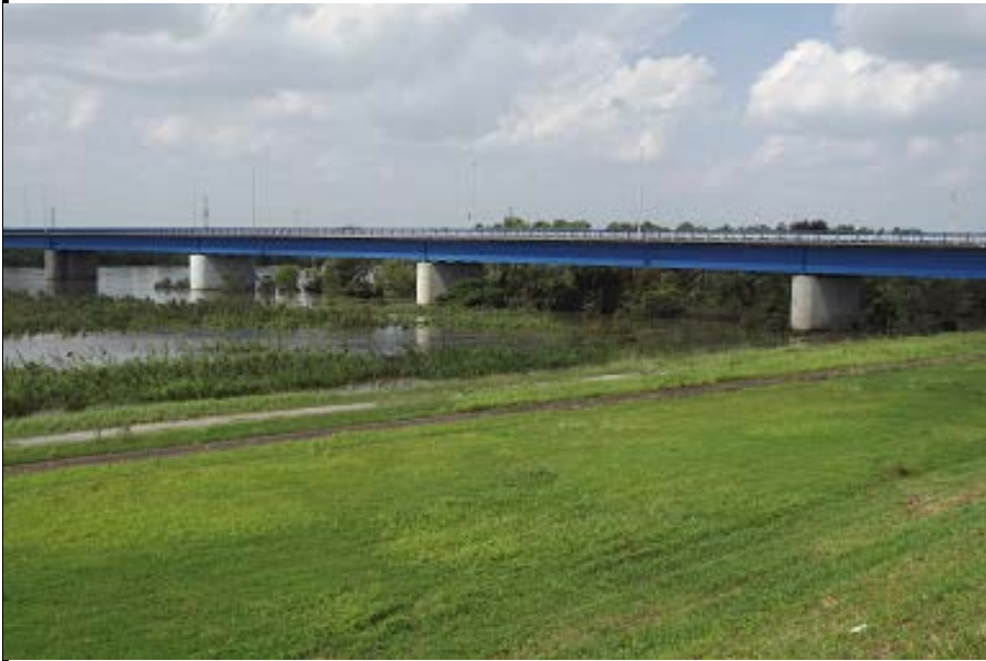
左岸6. 9KM地点台風の翌日の天端から見た上塚橋と水路
