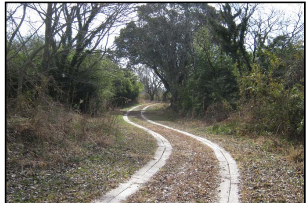
自然の中に枕木が 2 列に敷き詰めてあります
