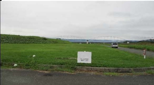
下流15km地点 右岸下流から
