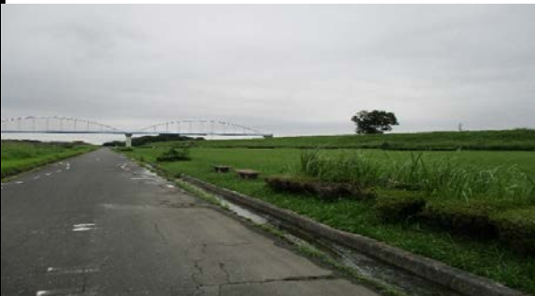
下流15km地点 右岸上流から
