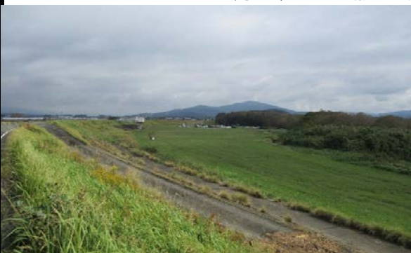
下流18, 5km地点 右岸下流から
