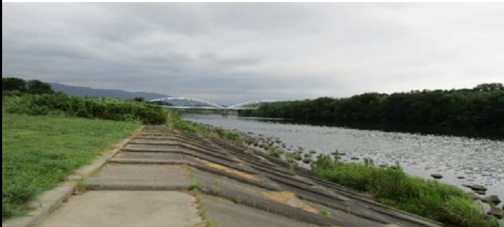
下流から25.5km地点 右岸 下流から
