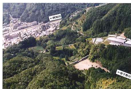
平成12年阿智村梨子野川土石流を止めた砂防えん堤
