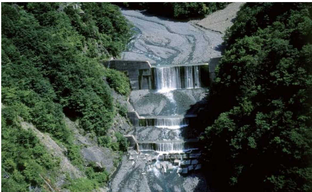
小波川源流の莫大な流出土砂を止める七釜砂防堰堤
