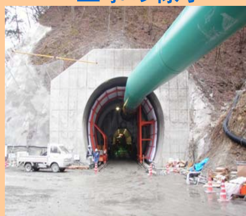
吐口坑門完成
