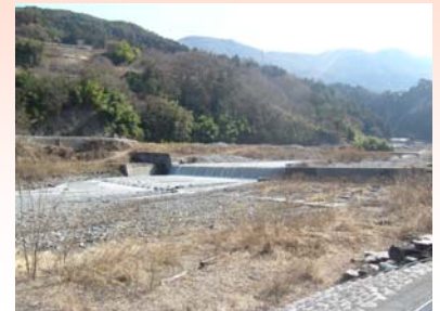
* 着工前の状況 (沢戸第1床固付近)
