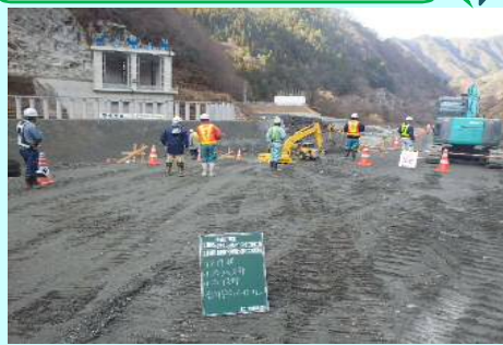
現場パトロールの実施状況 重機作業中の点検
