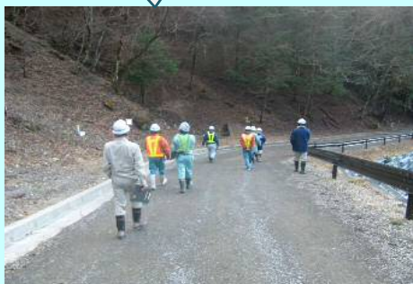
砂防堰堤現場
