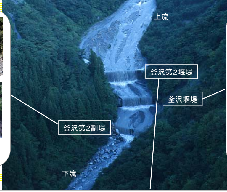
損傷の激しかった水通し部を、衝撃に強い ゴム素材 で補強しました
