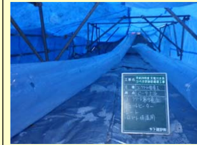
コンクリート打設後、シートで覆い、温風ヒーターを使用してコンクリートの温度が低下しないようにしています。
