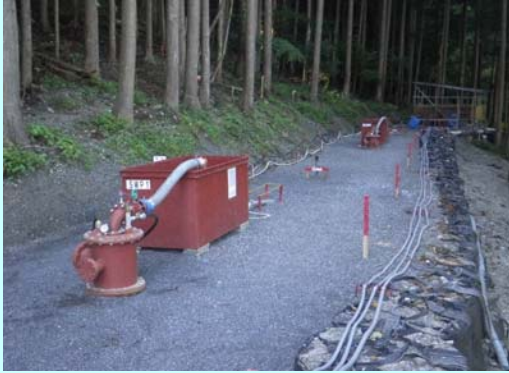
SWP施工完成(起点側)
