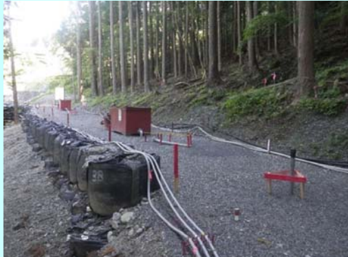
SWP施工完成(終点側)
