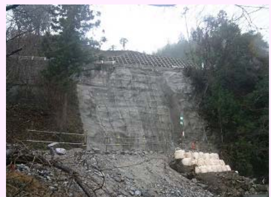
鉄筋挿入工 (スカイドリル工法) 岩盤へ鉄筋を串刺しにして 補強しました。
