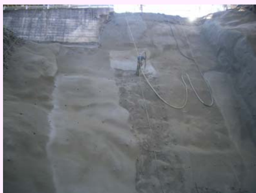
コンクリート吹付工
