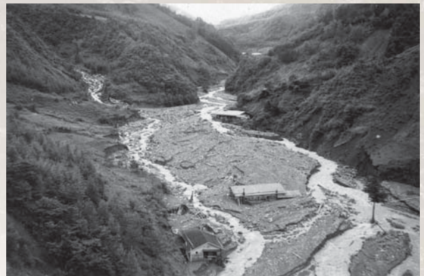
鹿塩川、北川分校付近の氾濫状況（大鹿村北川）
