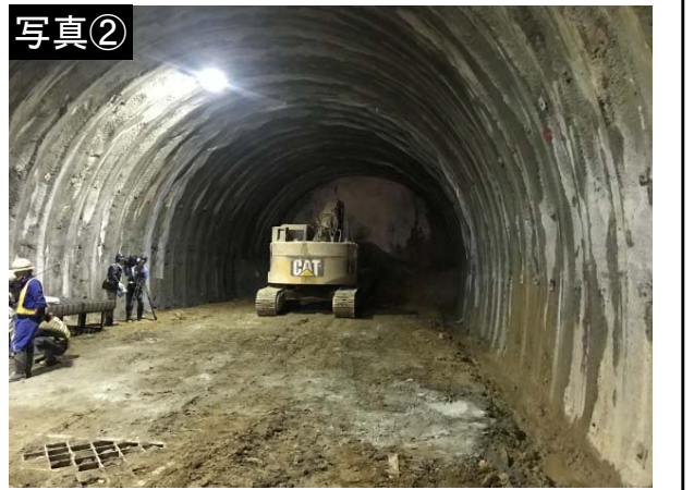
宮峠トンネル(仮称) 施工状況 (H30.9)
