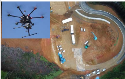
UAVによる起工測量
